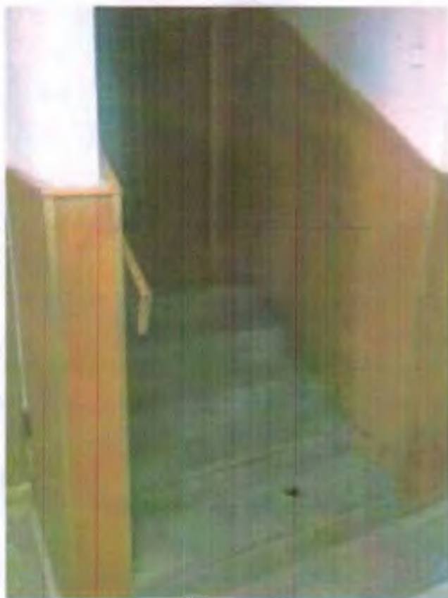
ВНУТРІШНІЙ ВИГЛЯД ОЦІНЮВАНИХ ПРИМІЩЕНЬ
